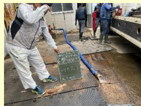
排水確認・完了
